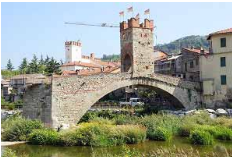
Millesimo, Ponte della Gaietta
