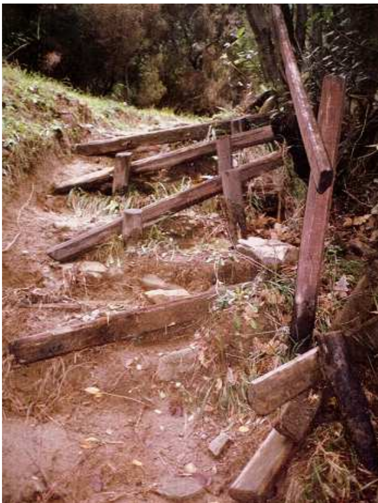
Danni provocati dalle moto in un altro tratto dove erano stati costruiti dei gradini per rendere agevole il passaggio (dicembre 2014)
