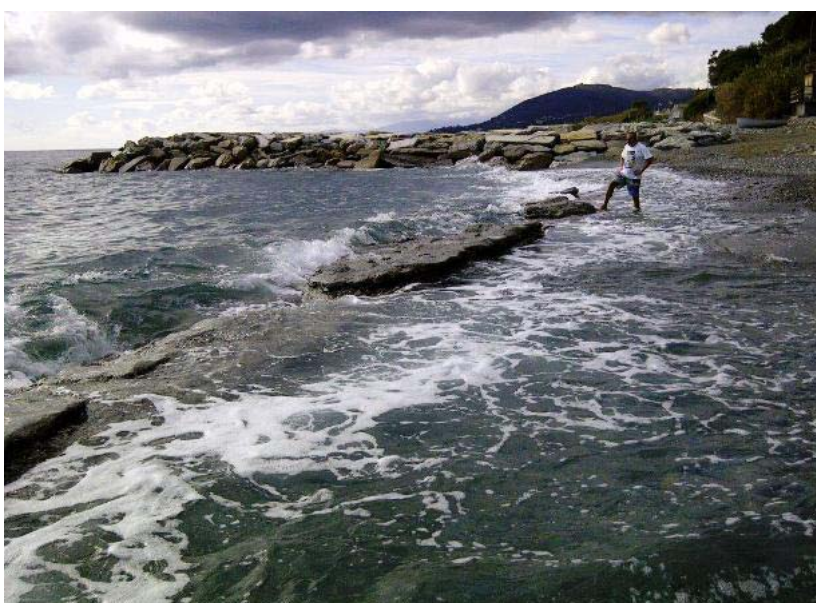
I crostoni affiorati a seguito di una mareggiata a novembre 2012
